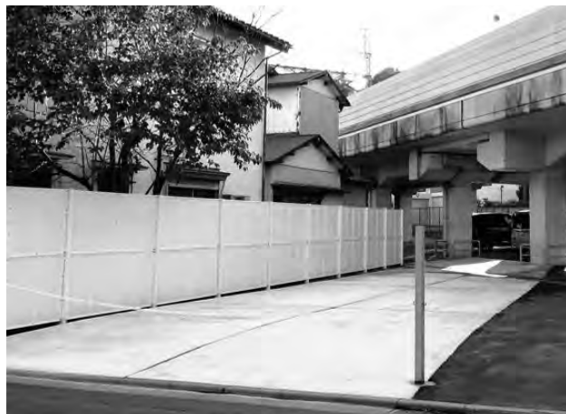
写真2 施工完了後の状況
