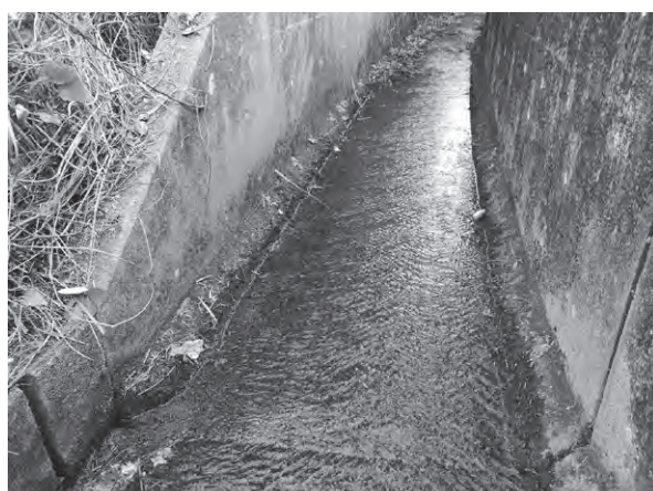
図2 湧水池に隣接する排水路
