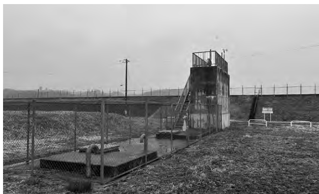
沖富調整池の流入工
