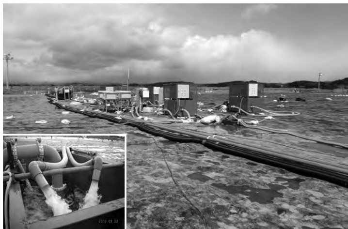
鉛直ドレーンの運転状況
