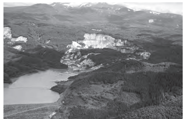
荒砥沢ダム上流の崩落状況
