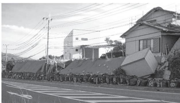
写真3 ブロック積み擁壁の崩壊
